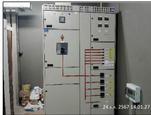
ภาพที่ 8 ระบบมอเตอร์ไฟฟ้าสำหรับระบบบำบัดน้ำเสีย
