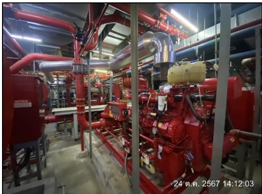
ภาพที่ 29 เครื่องสูบน้ำดับเพลิง
