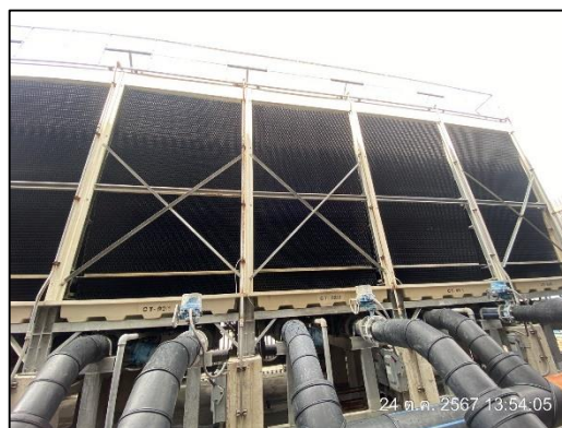
ภาพที่ 48 หอผึ่งเย็น (Cooling Tower)
