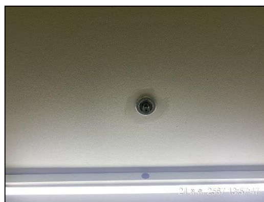
ภาพที่ 34 ระบบหัวกระจายน้ำดับเพลิง
