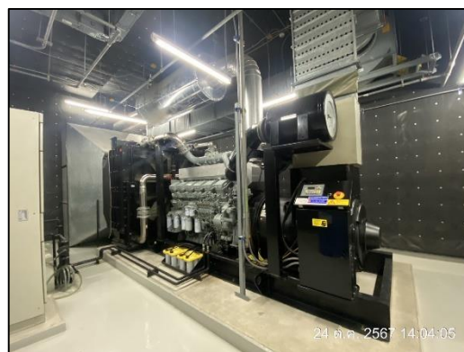
ภาพที่ 22 เครื่องกำเนิดไฟฟ้าสำรอง (Generator)
