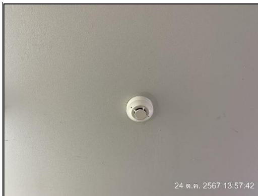
ภาพที่ 37 เครื่องตรวจจับควัน และเครื่องตรวจจับความร้อน
