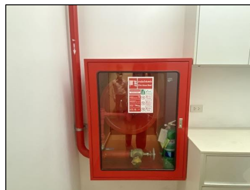
ภาพที่ 32 ตู้เก็บสายฉีดน้ำดับเพลิงพร้อมอุปกรณ์
