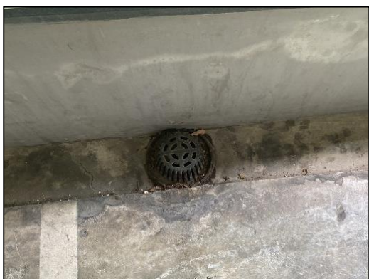
ภาพที่ 56 ตะแกรงครอบรูท่อระบายน้ำ
